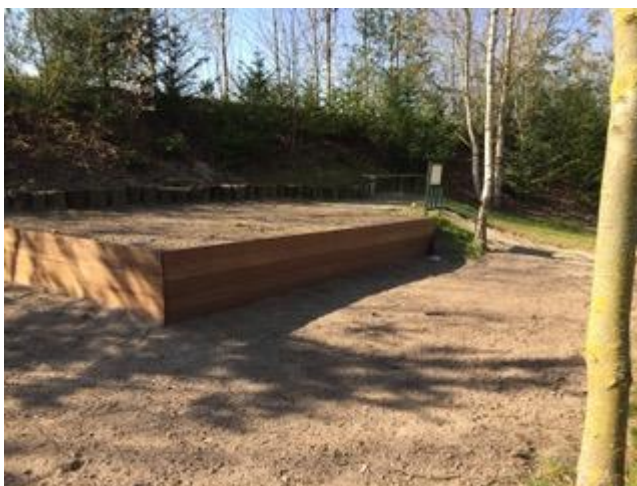
De afslag zelf is afgerand met houten planken en het geheel is klaar om ingezaaid te worden.
