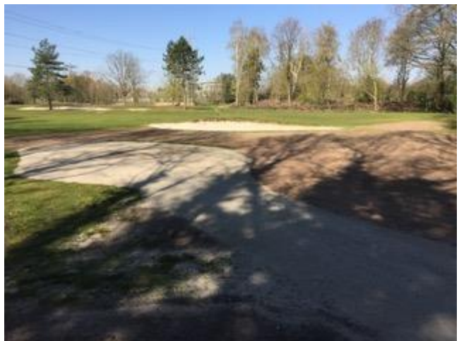
De blubber is weg en alle paden in de baan zijn nu bedekt met Puingravel gemengd met cement. Bij regenval en veelvuldige rijbewegingen met de buggies worden de paden hard en stevig.....
